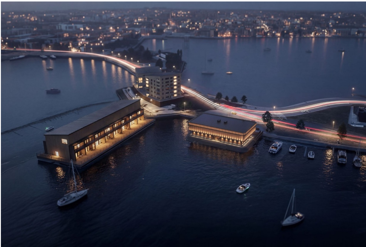
Le Musée national suédois de la musique, en cours de construction à Slotsholmen sur l'eau, sera situé à proximité des ruines du château de Stegeholm, où se tient le légendaire festival de musique de Västervik. Photo : OKIDOKI Architects ( Télécharger )
